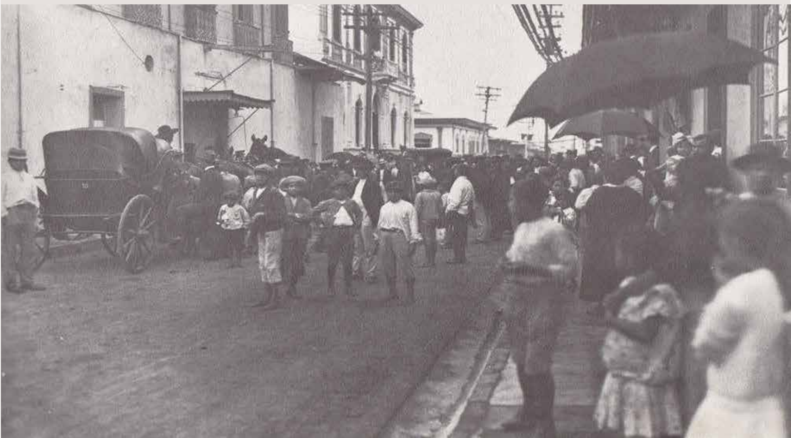
La Avenida Tercera, hacia el oeste, entre Calles Segunda y Cuarta, en 1916. A la izquierda, en la esquina, la Imprenta Nacional, donde posteriormente estuvo la Caja Costarricense de Seguro Social y ahora se aloja la torre del Banco Nacional de Costa Rica.
