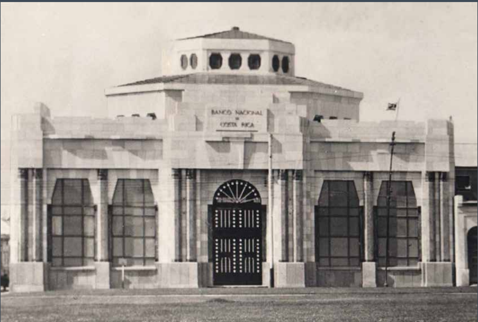
Edificio del Banco Nacional de Costa Rica, inaugurado el 1 de Enero de 1937. Fuente: Archivo fotográfico del Banco Nacional.
