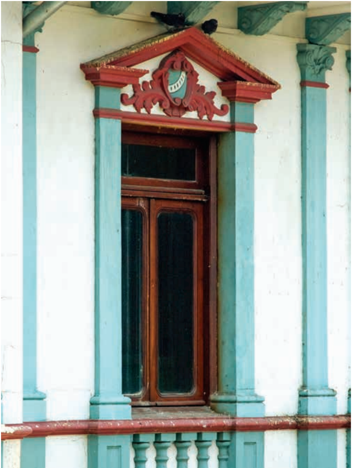
Antañón y neoclásico, el original edificio del Banco Anglo Costarricense todavía mira a la Avenida Central desde sus ventanas.
