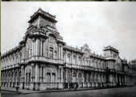
El Edificio de Correos y Telégrafos hacia 1920.
