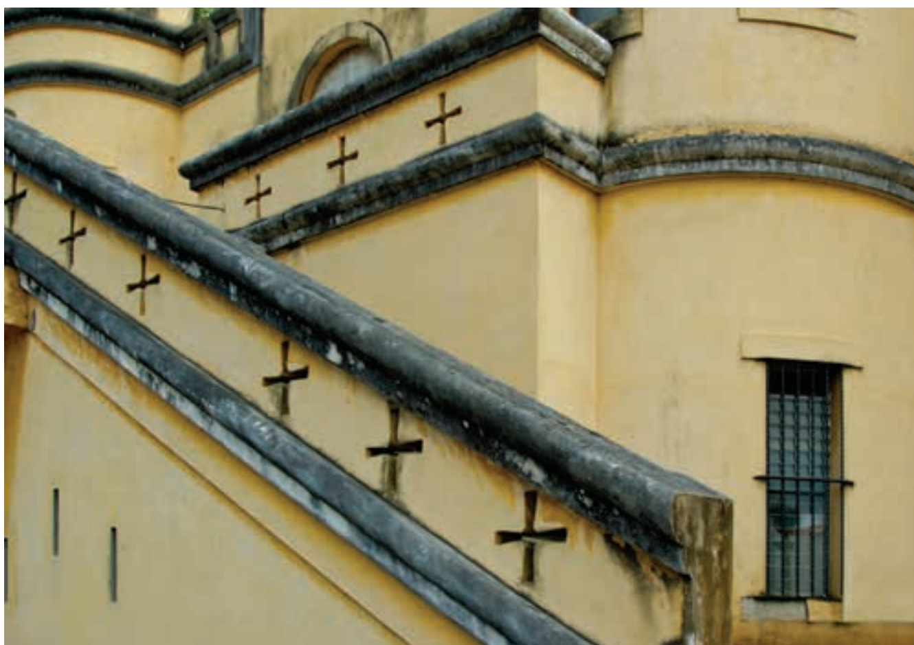
Troneras y escalinatas en la fachada, nos recuerdan apenas nuestro pasado militar.
