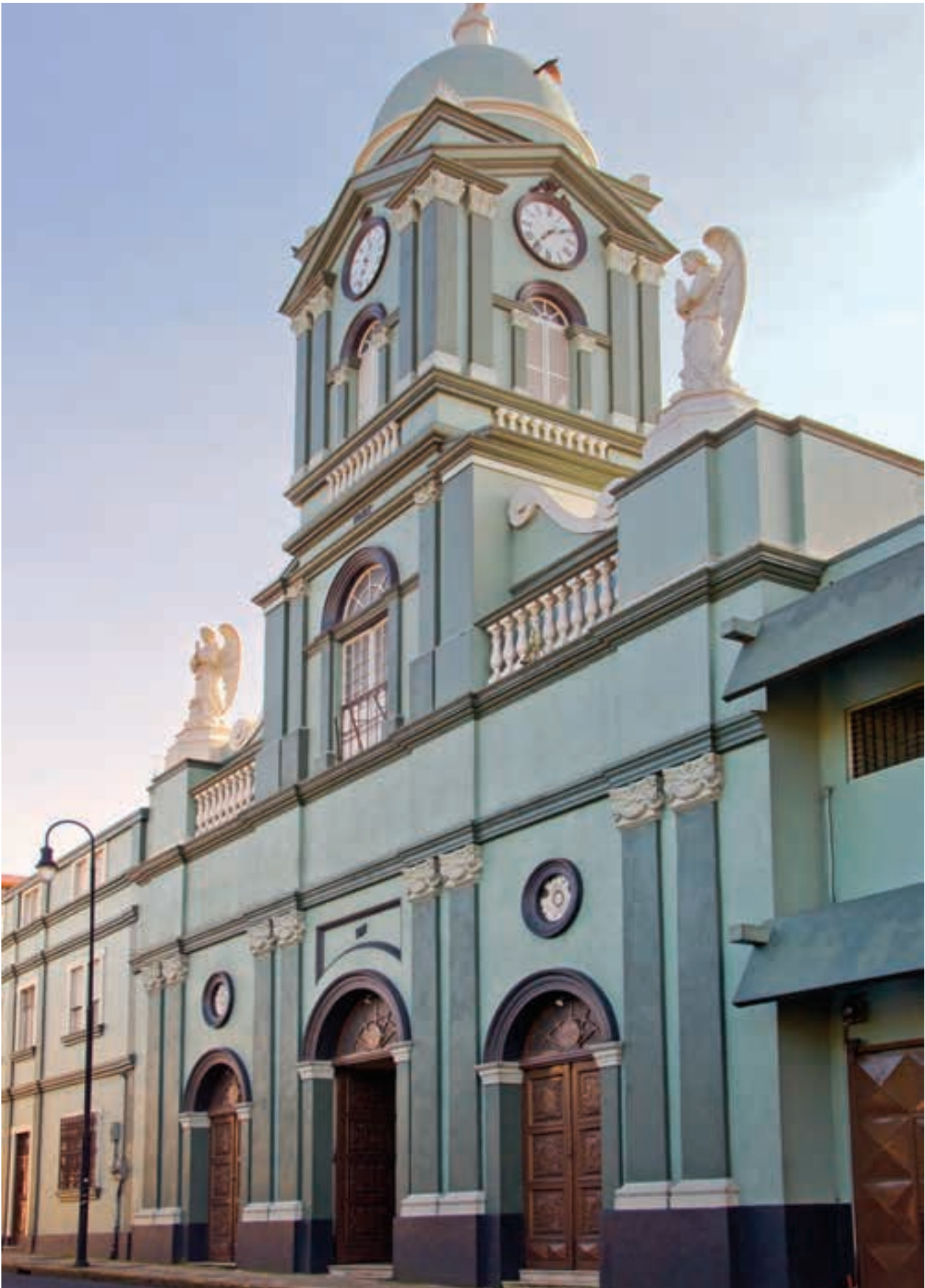
Finalizada en 1943, la última remodelación de la iglesia, nos da ella un aspecto neoclásico de discretos tintes barrocos.
