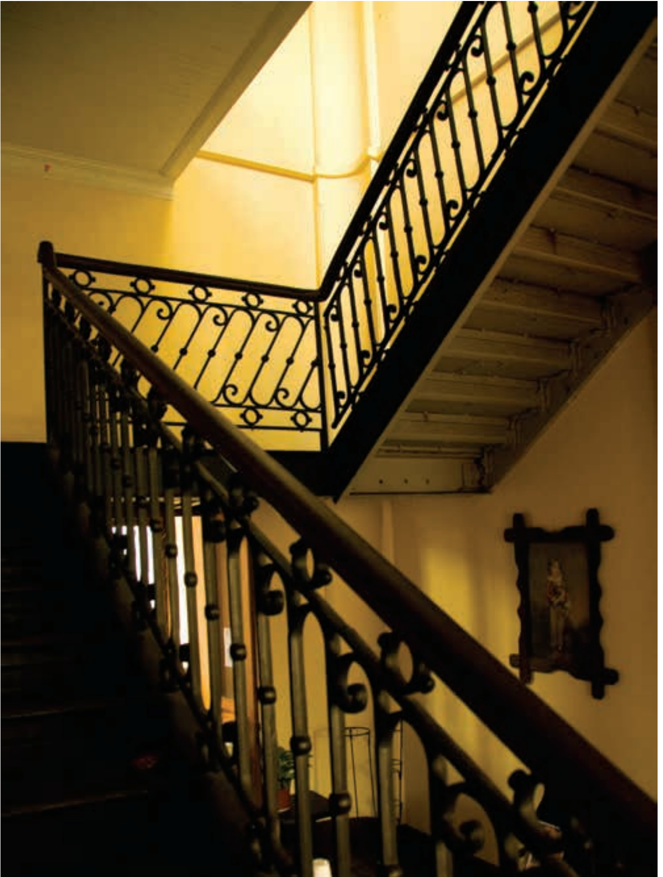
En hierro forjado, la escalera neoclásica del Colegio Superior de Señoritas.
