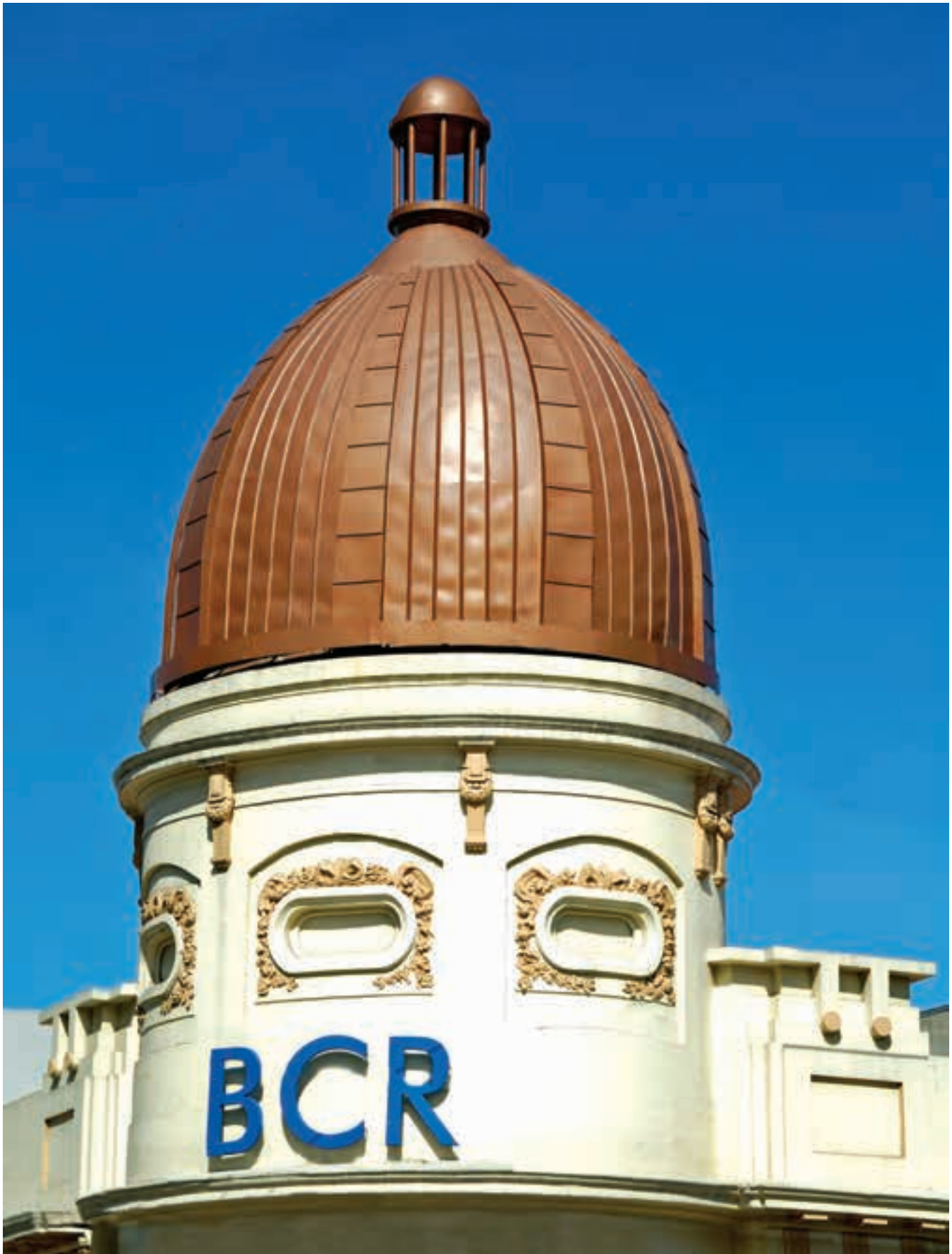
Hoy agencia del Banco de Costa Rica, el edificio de la antigua Ferretería Espriella luce aún su característica cúpula de bronce.
