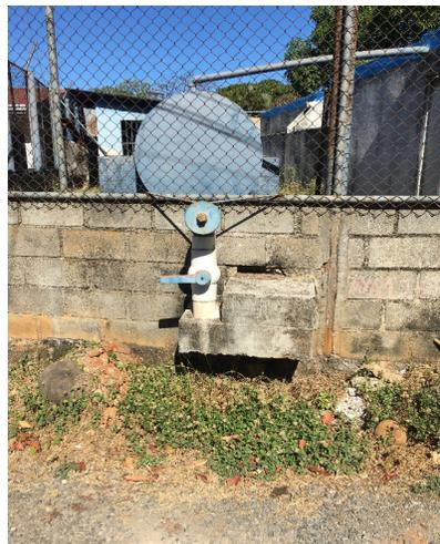
**Fotografía 11. Hidrante abastecido por tanque metálico.**
