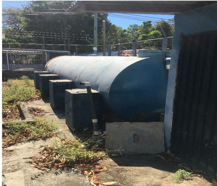
**Fotografía 10. Tanque cilíndrico metálico.**
