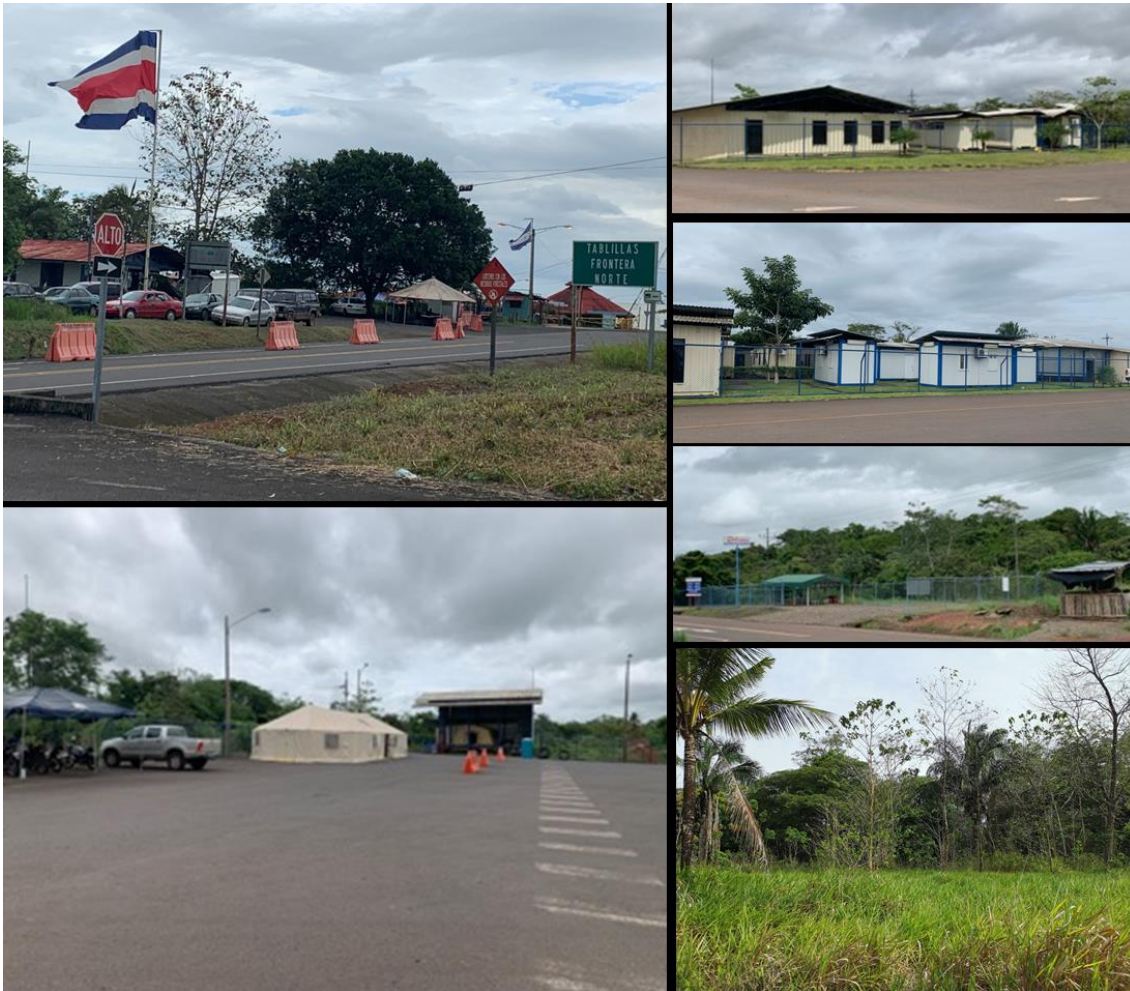
Figura 3. Puesto Fronterizo Las Tablillas, Los Chiles, Alajuela. Nótese amplio parqueo y construcciones temporales creadas en 2014 a partir de contenedores.
