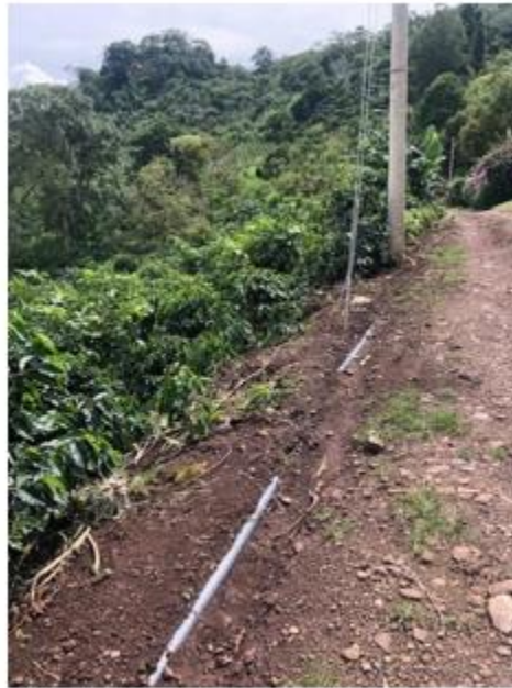
Fotografía 3. Topografía y vista de la servidumbre de paso de tubería a constituir.
