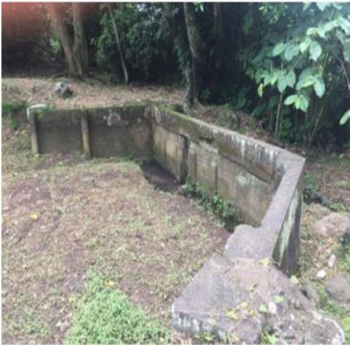
Fotografía 1. Vista actual de la estructura de antiguo estanque
