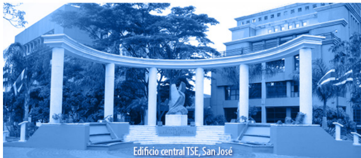
Edificio central TSE, San José
