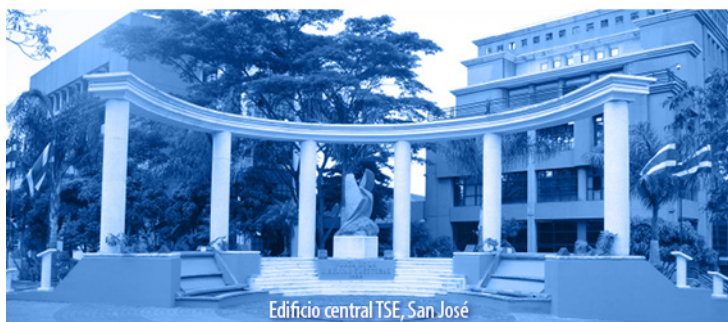
Edificio central TSE, San José
