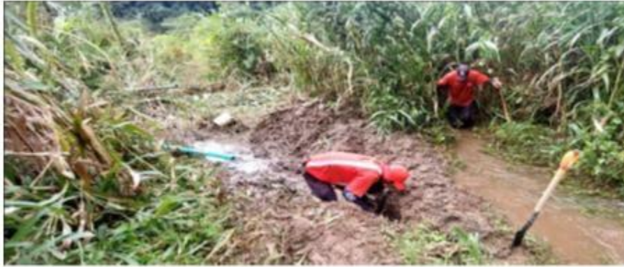
Imagen 4. Atención de emergencia – sistema de Purisil/
