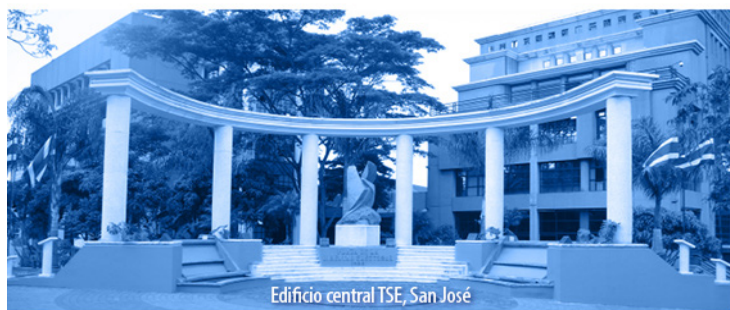
Edificio central TSE, San José
