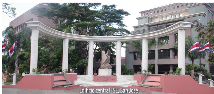
Edificio central TSE, San José
